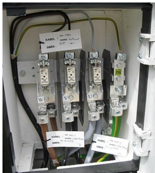
Obr. 5.1: Příklad zapojení hlavní domovní skříně 28
